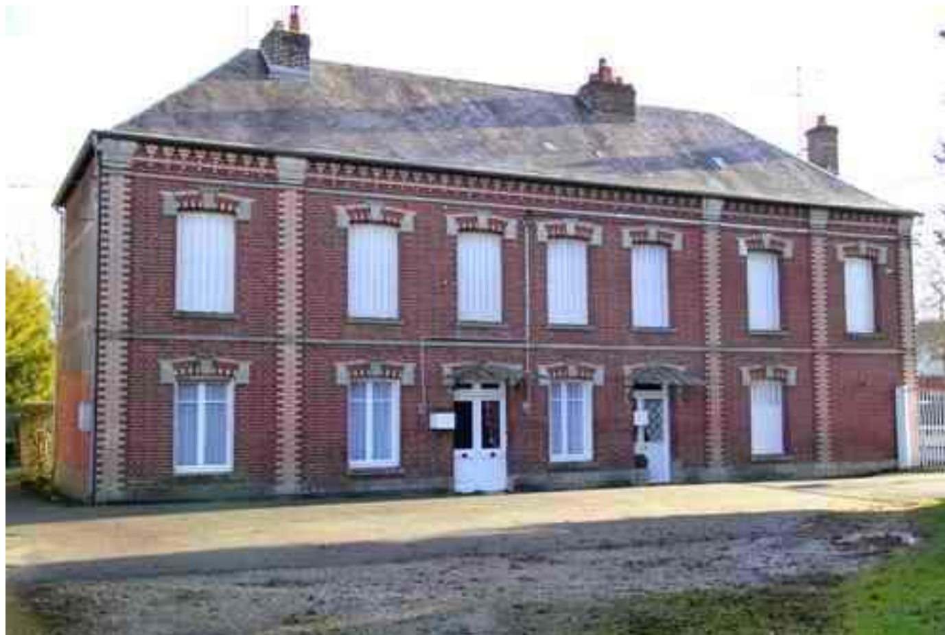
Annexe 1 : Photo du bâtiment destiné à être le gîte.
